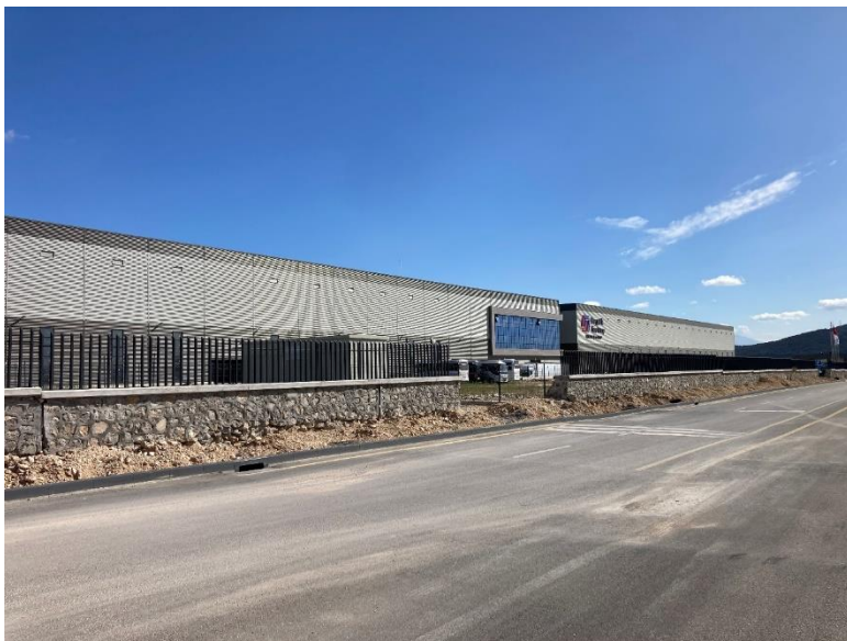
LiCON-Success-Story-Celikform-2.jpg Il nuovo stabilimento Celikform presso il sito TEKNOSAB
